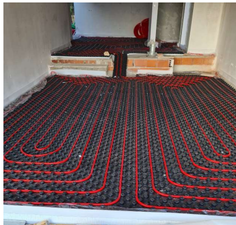
Figura 3.10 Pavimento isolado no modelo digital e no edifício real
