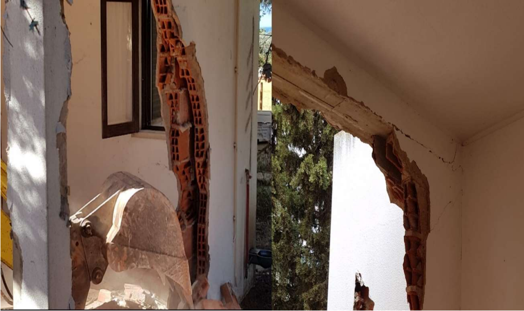
Figura 3.3 Paredes exteriores (T7+Ar+T7) antes da remodelação
