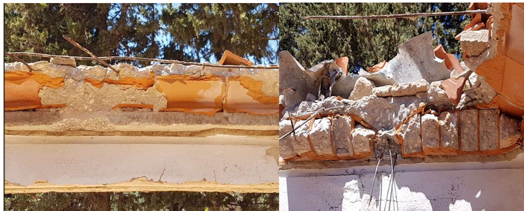
Figura 3.6 Cobertura antes da remodelação
