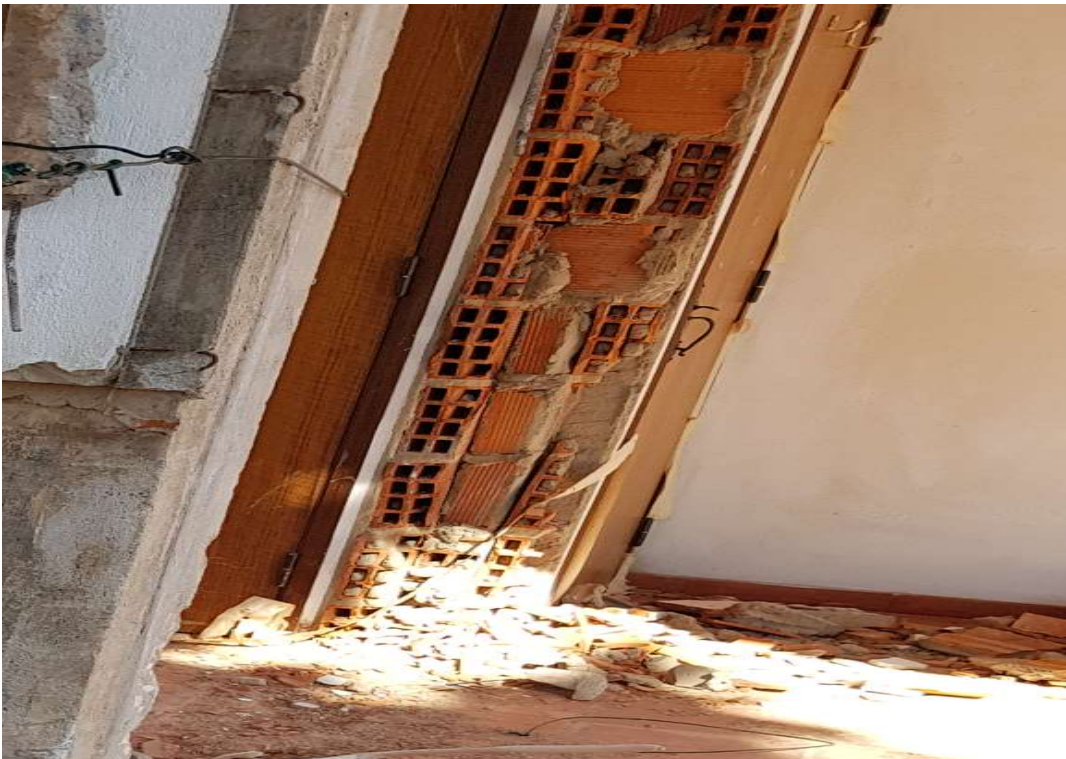
Figura 3.3 Paredes exteriores (T7+Ar+T7) antes da remodelação
