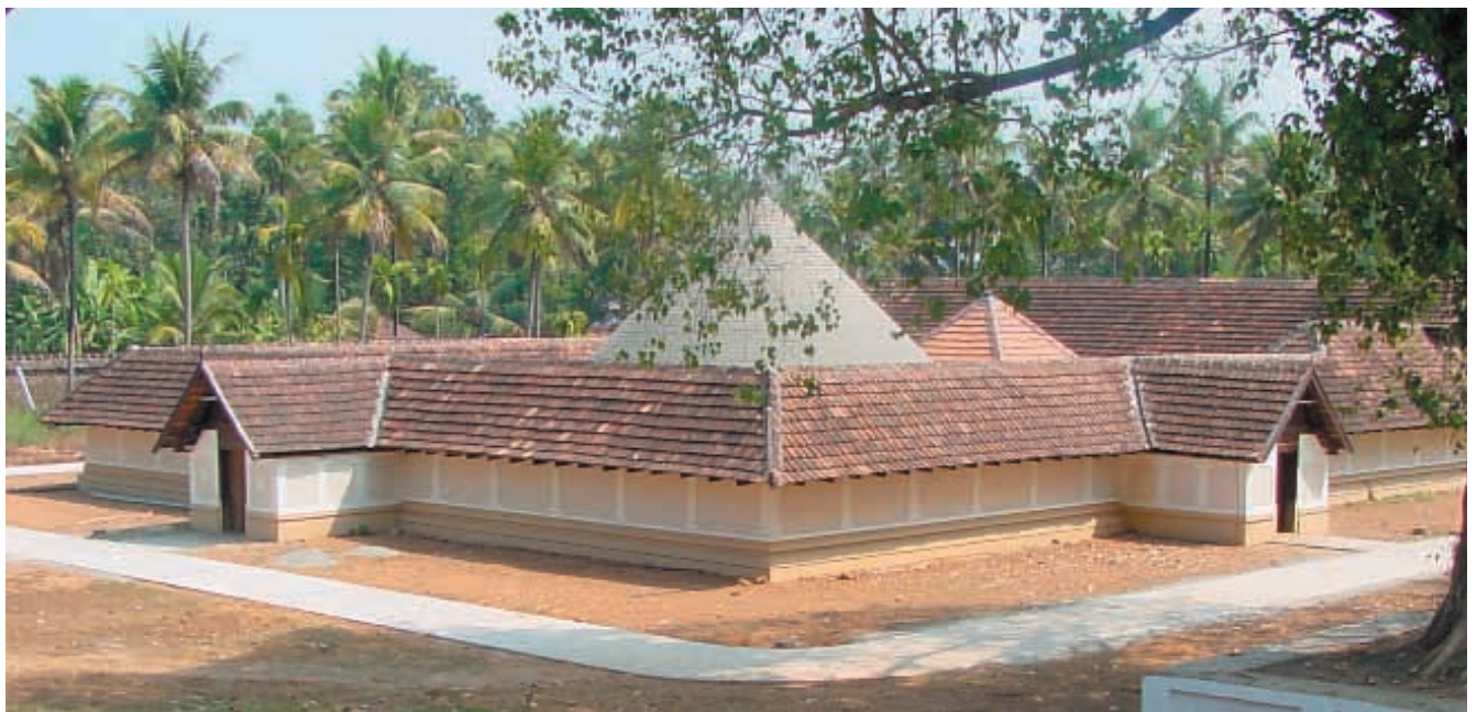
VISTA GERAL DO NÚCLEO CENTRAL DO TEMPLO DE SRIRANARAYANA. THIRUNAYATHODE. DISTRITO DE KOTTAYAM
