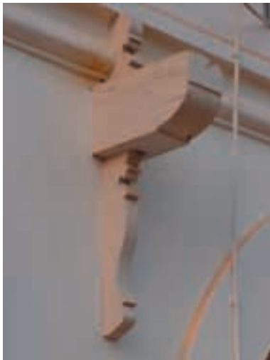
PORMENOR DE TRAVAMENTO EXTERIOR DE BARROTE COM CAVILHA TRABALHADA. IGREJA DE CHERIYAPALLY. KOTTAYAM.
