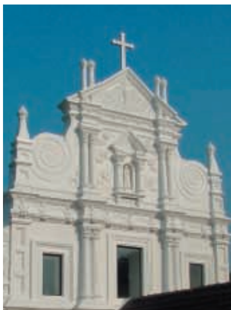
VISTA GERAL E PORMENOR DE FACHADA DA IGREJA DE SANTA MARIA DE CHERIYAPALLY. KOTTAYAM.
