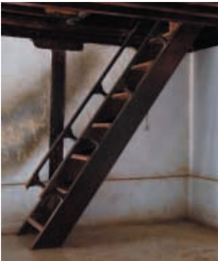
INTERIOR E ESCADA DE ACESSO AO ANDAR SUPERIOR. PALÁCIO PADMANABHAPURAM. NAGERCOIL
