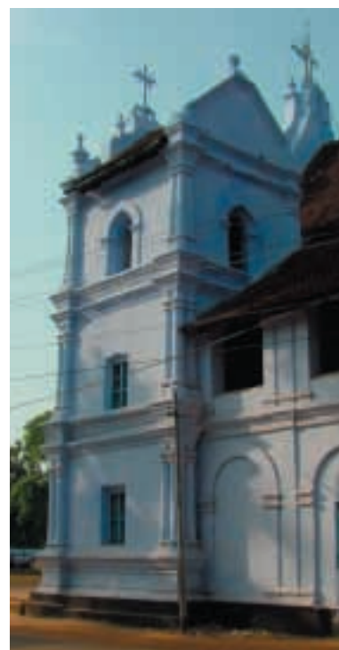
TORRE DA FACHADA PRINCIPAL E PORMENORES DA GALERIA LATERAL DE PARTICULAR IMPORTÂNCIA PARA A CONFIRMAÇÃO DA ÉPOCA DE CONSTRUÇÃO DA IGREJA O TARDOZ DA TORRE AINDA APRESENTA ELEMENTOS DO SÉCULO XVII COMO O PINÁCULO EM BOLA DE CANHÃO E OS ARCOS EM VOLTA PERFEITA QUE DESAPARECERAM NA FACHADA. IGREJA DE SÃO TOMÉ DE THUMPOLY
