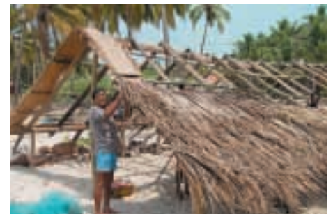
CONSTRUÇÃO DE ABRIGO PARA BARCOS EM COBERTURA DE PALMA NA COSTA DO MALABAR.
