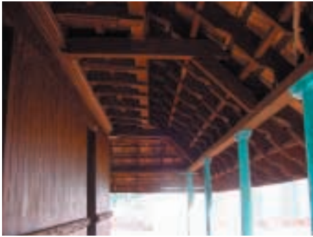
EM CIMA E EM BAIXO. PORMENOR DA VARANDA DA CASA PAROQUIAL DA IGREJA DE PUTUPPALY DISTRITO DE KOTTAYAM
