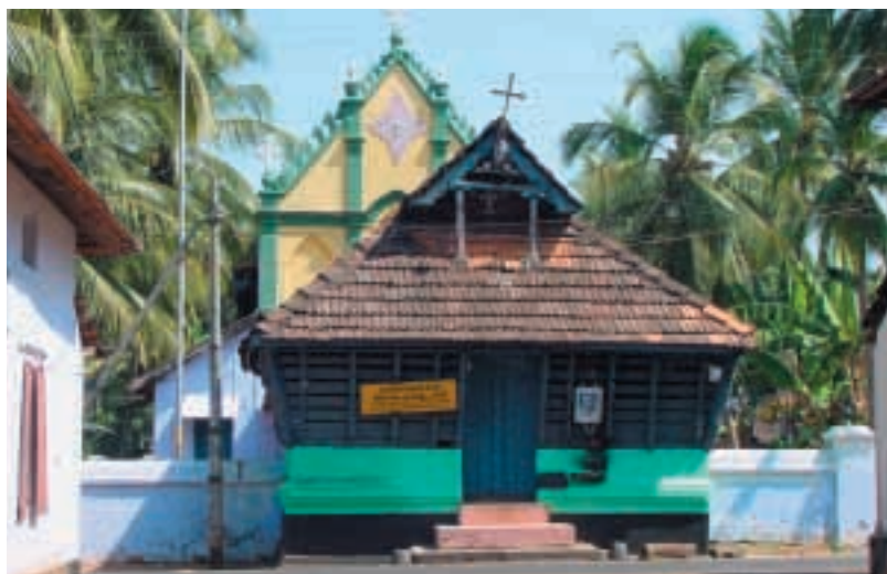
ALPENDRE EM MADEIRA SOBRE SOCO EM PEDRA. IGREJA DE SÃO MATIAS, KULAMKULAM. DISTRITO DO THRICHUR
