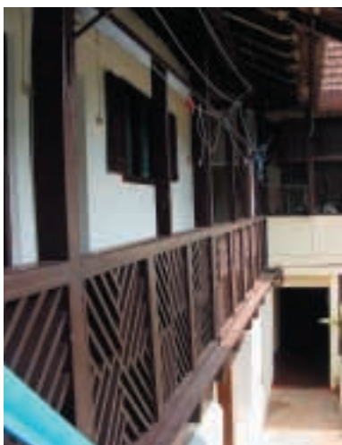
VISTA DA FACHADA PRINCIPAL E PORMENOR DE VARANDA DO JARDIM. CASA DO ANTIGO NÚCLEO MANUELINO DE COCHIM.
