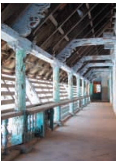
VISTA GERAL DA FACHADA PRINCIPAL E PORMENOR DA VARANDA DA CASA PAROQUIAL DA IGREJA DE SANTA MARIA DE KURUPPAMPADY. DISTRITO DE KOTTAYAM
