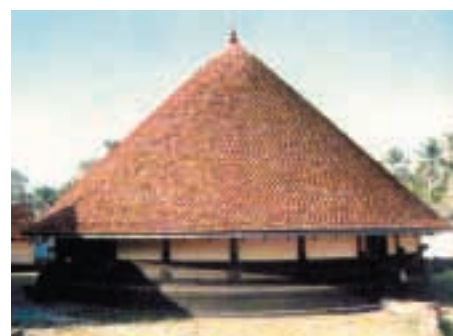
NÚCLEO CENTRAL “VIMANA” COM COBERTURA TRADICIONAL EM PLACAS DE CERÂMICA. TEMPLO DE ULIYANNOOR, ALUVA, DISTRITO DE ERNAKULAM.
