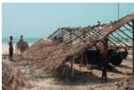
CONSTRUÇÃO DE ABRIGO PARA BARCOS EM COBERTURA DE PALMA NA COSTA DO MALABAR.
