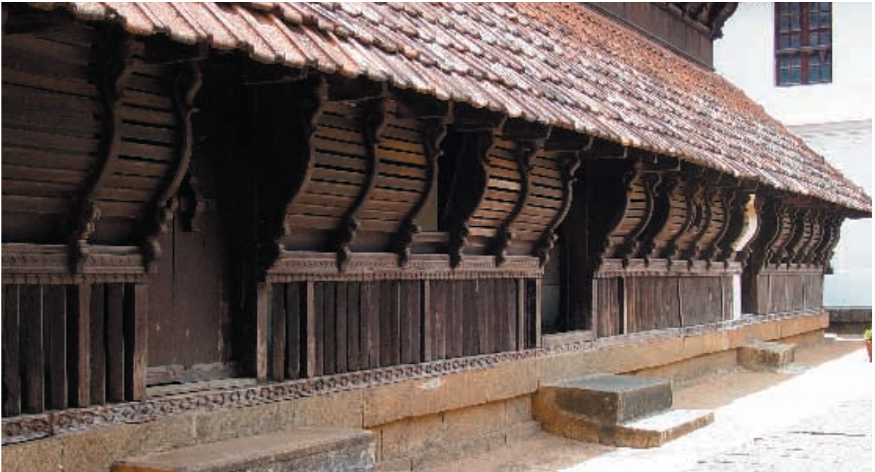
PAVILHÃO EM ESTRUTURA DE MADEIRA NO PALÁCIO PADMANABHAPURAM. NAGERCOIL
