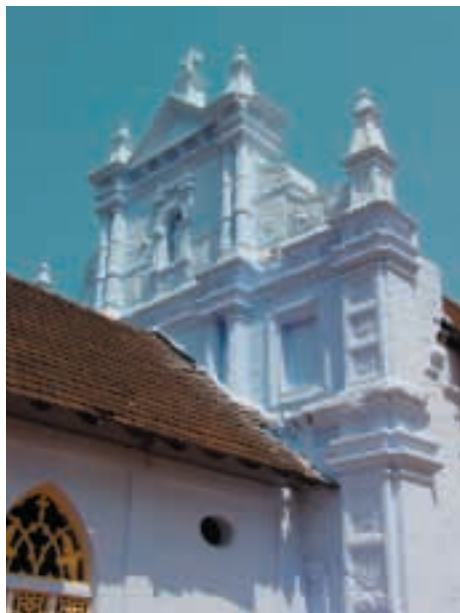
FACHADA DA IGREJA DE SANTO HORMISDAS. ANGAMALY
