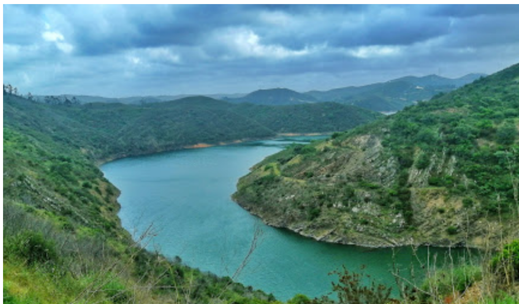
Imagem 3.5 - Fotografia da barragem do rio Arade. Fonte: Google maps.
