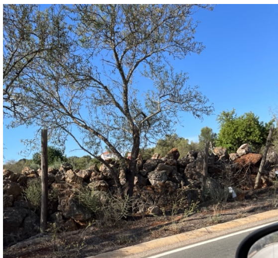
Imagem 3.9 - Fotografia de muro de pedra seca em abandono. Fonte: autora, 2023.
