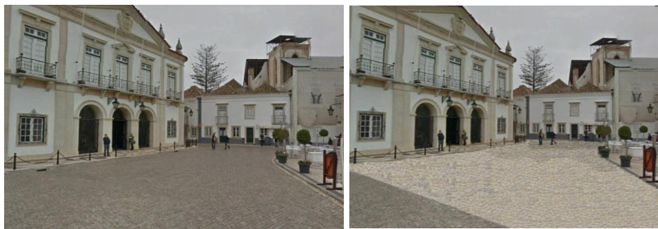
Figura 6.32 - Antes e após a intervenção no Largo da Sé.
