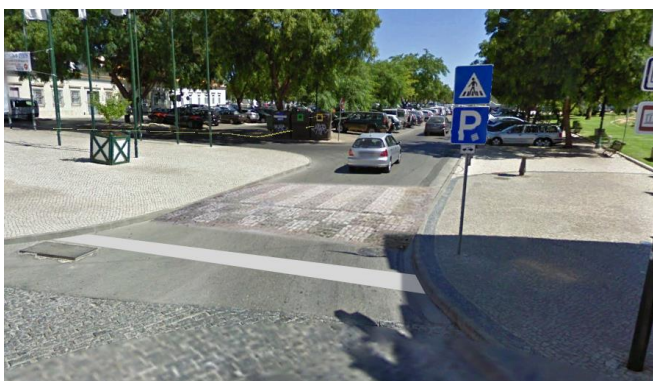
Figura 6.29 - Após a proposta de intervenção de passadeira sobrelevada junto ao Arco do Repouso.
