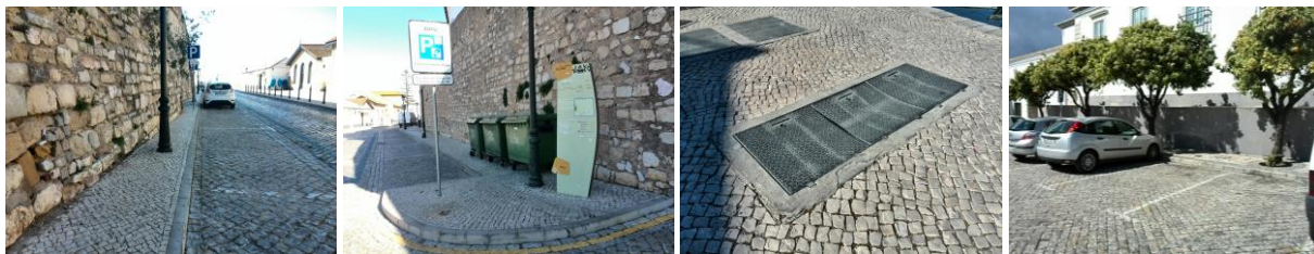
Figura 6.17 - Levantamento fotográfico das situações com obstáculos fixos à circulação pedonal, nomeadamente iluminação pública, sinalética, sinalização de trânsito, contentores e tampas no pavimento na Rua Comandante Francisco Manuel árvores no Largo da Sé. [12/03/2015]
