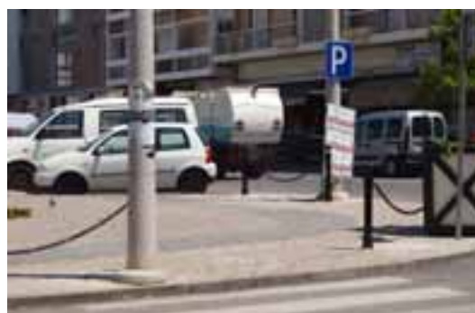
Largo de S. Luís – Ausência de rebaixamento de lancil na zona da passadeira, inacessível às pessoas em cadeiras de rodas
