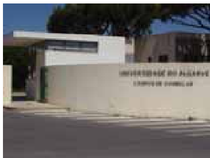
Gambelas – Ausência de rebaixamento de lancil
