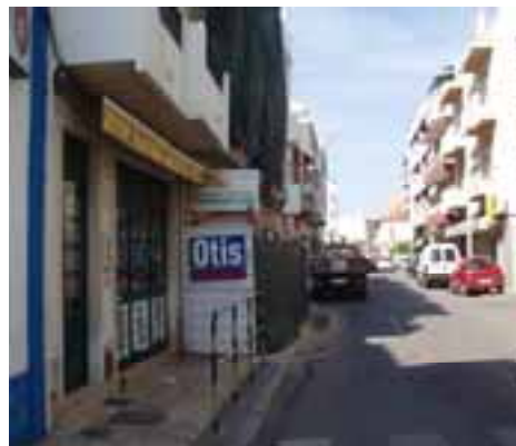
Estrada de São Luís – Tapumes obstruindo o espaço pedonal sem oferecer alternativa à passagem de peões
