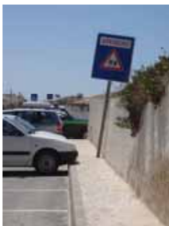
Praia de Faro – Passeios estreitos, sem rampas de acesso
