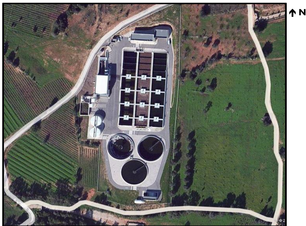
Figura 3.1.1 - Imagem aérea da ETAR de Albufeira Poente. Fonte: Google Earth, acedido em 30 de outubro 2014
