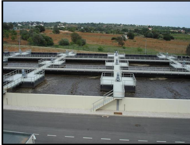
Figura 3.1.4 – Tratamento biológico – reatores biológicos
