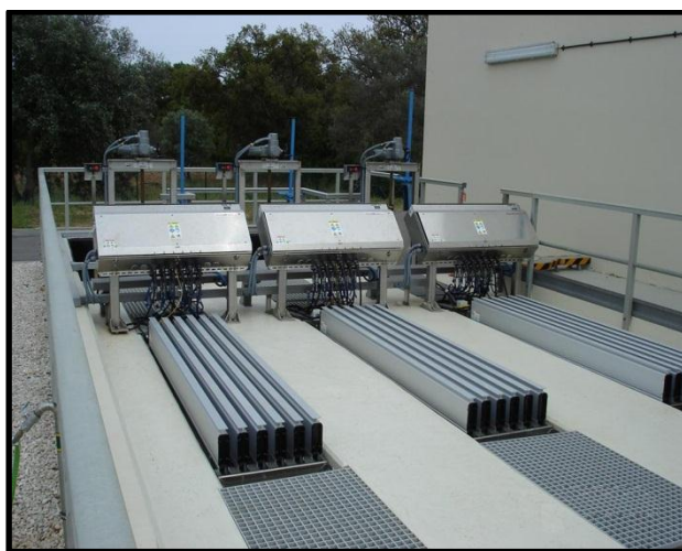
Figura 3.1.7. – Desinfecção - Canais UV
