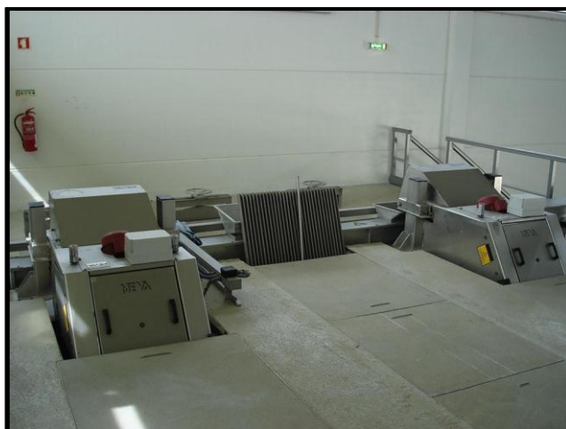
Figura 3.1.2 – Tratamento preliminar - Gradagem mecânica e manual
