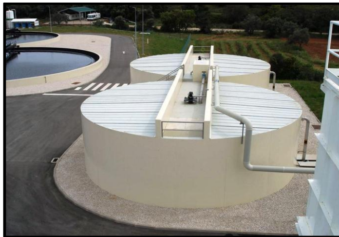
Figura 3.1.10 – Fase sólida - Espessamento gravítico
