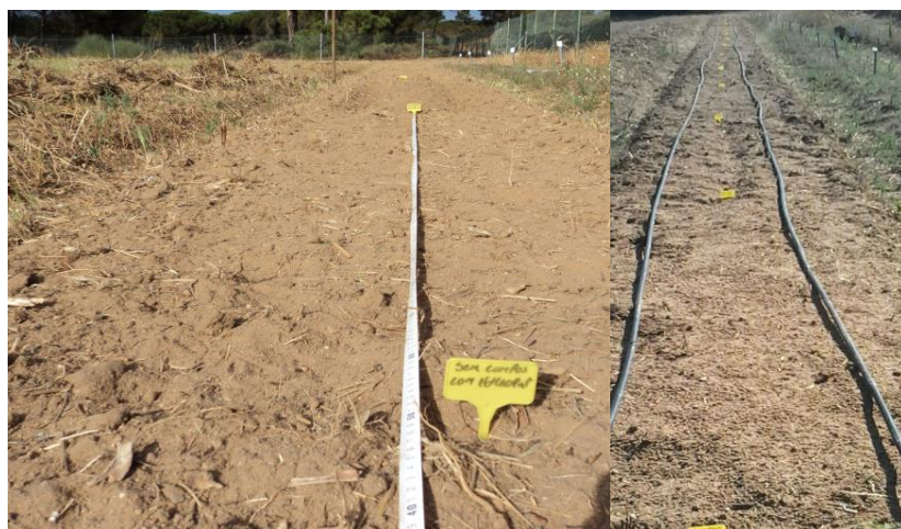
ILUSTRAÇÃO 9-1 Preparação do terreno, instalação sistema de rega
