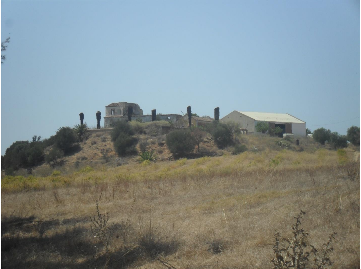
Figura Nº 3. Uma panorâmica sentido Este-Oeste do monte da Quinta de Torre de Aires. As antigas estruturas da quinta poderão estar por cima do fórum de Balsa. (Foto do autor, Agosto, 2019).
