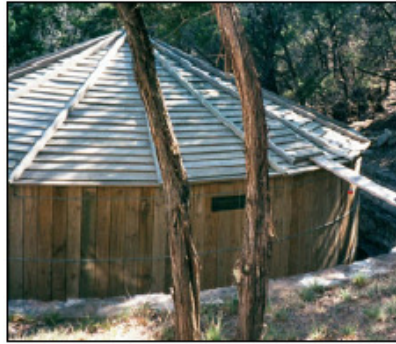
Figura 16 – Reservatório em Madeira
