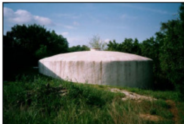
Figura 11 – Reservatório em Ferrocimento
