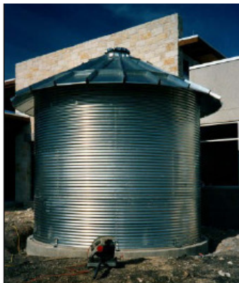
Figura 14 – Reservatório em Aço Galvanizado
