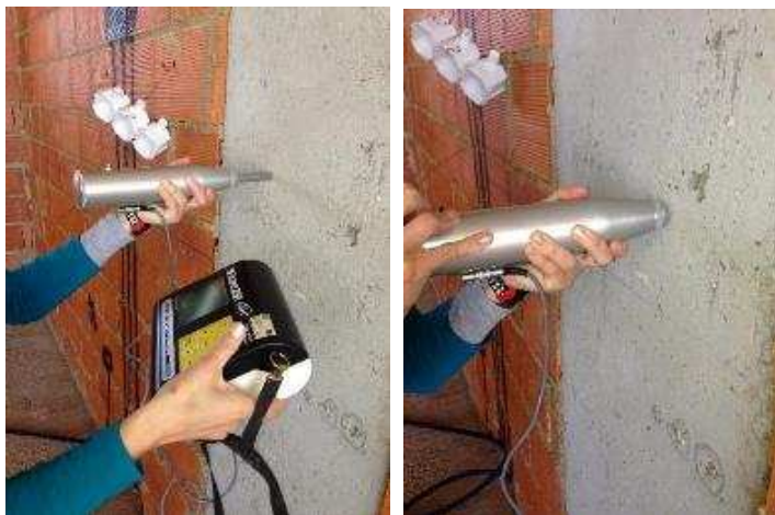
Figura 5.39 – Ensaio esclerométrico para avaliar a resistência à compressão do betão
