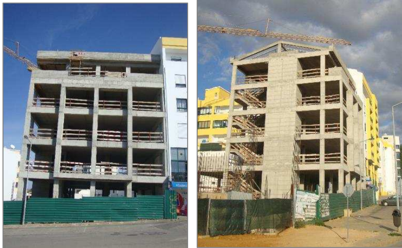
Figura 7.29 – Vista exterior do edifício 2
