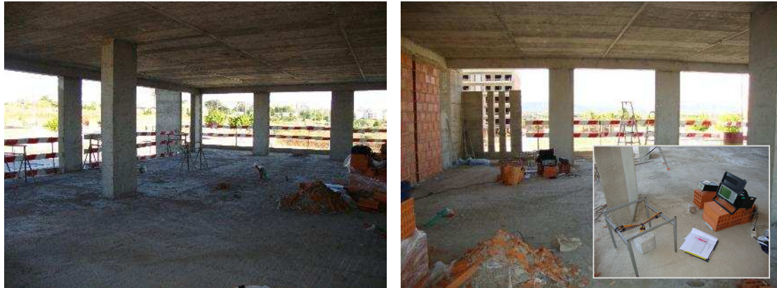
Figura 7.50 – Vista interior do edifício 3
