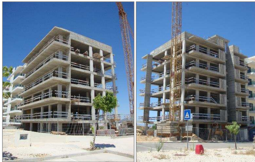
Figura 7.49 – Vista exterior do edifício 3
