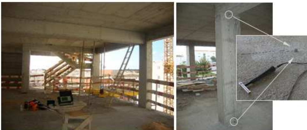
Figura 7.30 – Vista interior do edifício 2
