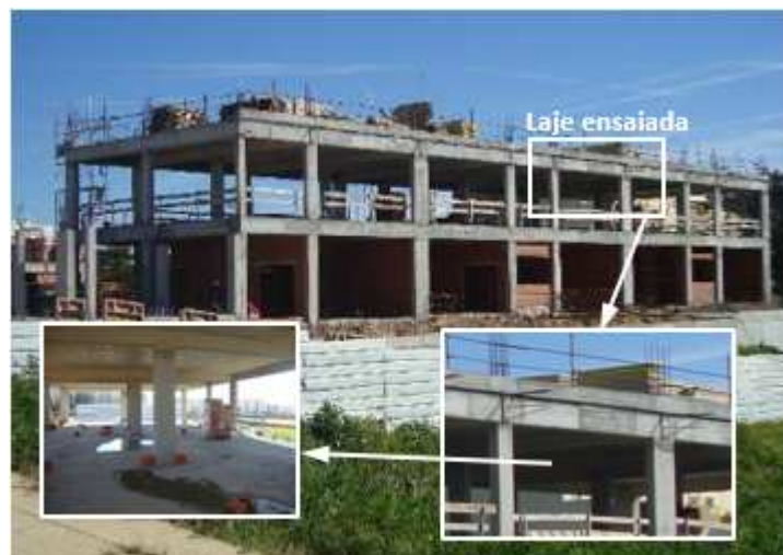
Figura 5.38 – Vista geral do edifício e pormenor da laje ensaiada experimentalmente
