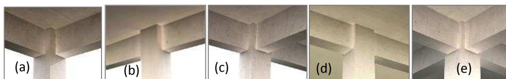
Figura 7.1 – Ilustração da tipologia dos nós de pilares considerados no método simplificado
