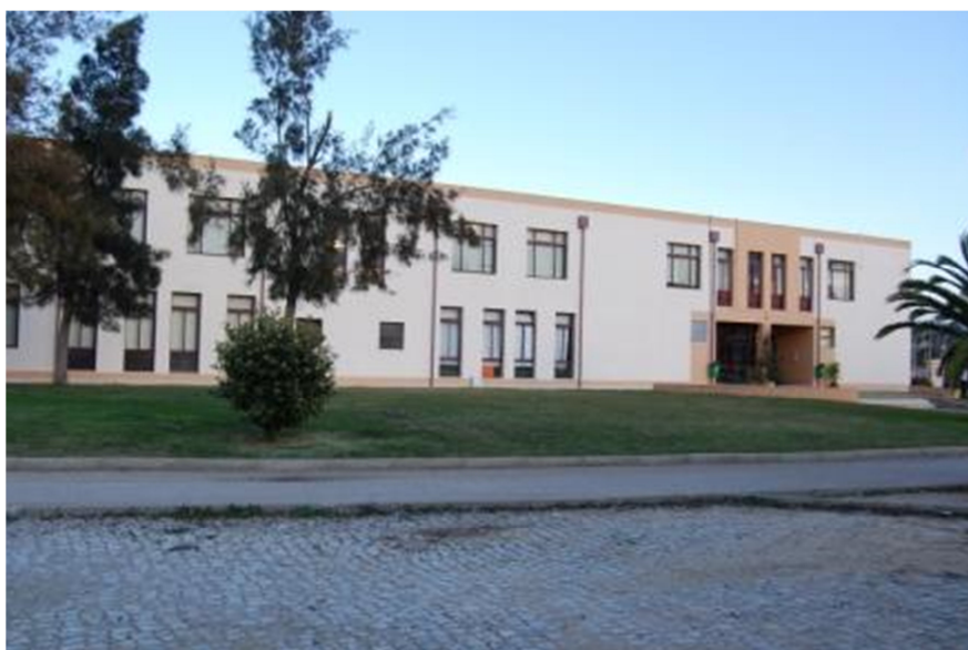
Figura 1.1 - Fachada da Escola EB Padre João Coelho Cabanita
