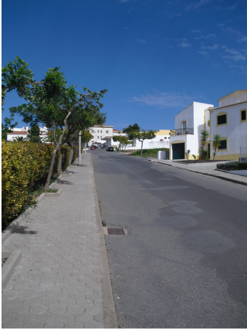
Figura 2.19: Acesso sul - Rua dos Bombeiros Voluntários
