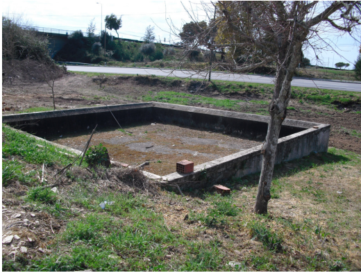
Figura 2.21: Antigo reservatório de água.
