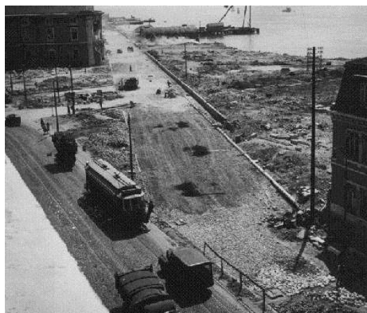
Figura 3.51 – Avenida da Ribeira das Naus em construção (Fonte: Wikipédia).
