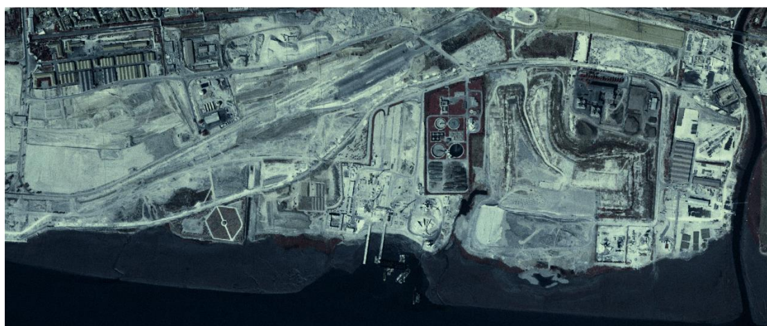
Figura 3.8 - ETAR e Aterro Sanitário de Beirolas. 1995 (Fonte: Ortofotos 1 m - Portugal Continental – 1995. Direção Geral do Território. EPSG:3763).
