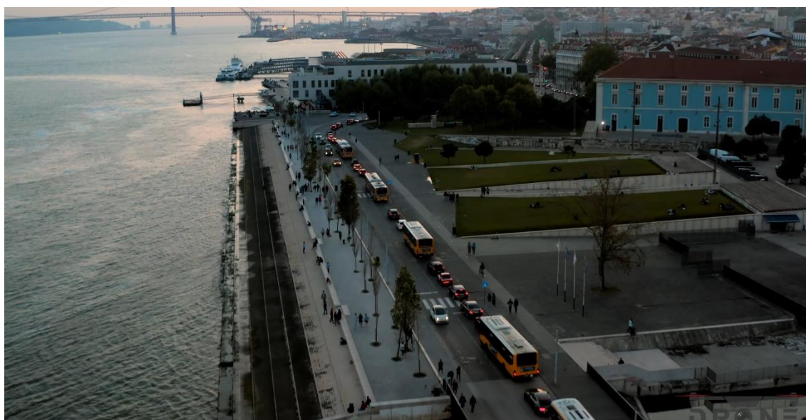
Figura 3.55 – A nova zona da Ribeira das Naus (Fonte: Drone Snap).
