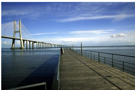
Figura 3.11 - Parque Tejo e Trancão, passadiço sobre o Tejo (Fonte: PROAP).
