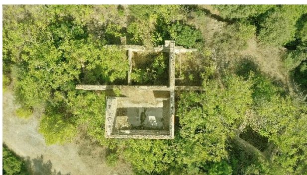
Figura 5.16 – Imagem drone Casa Del Direttore em planta (Fonte: PROAP Servidor).
