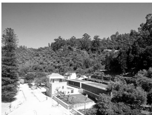
Figura 3.16 - Hotel INATEL Gavião, inserido na paisagem (Fonte: Habitar Portugal).
