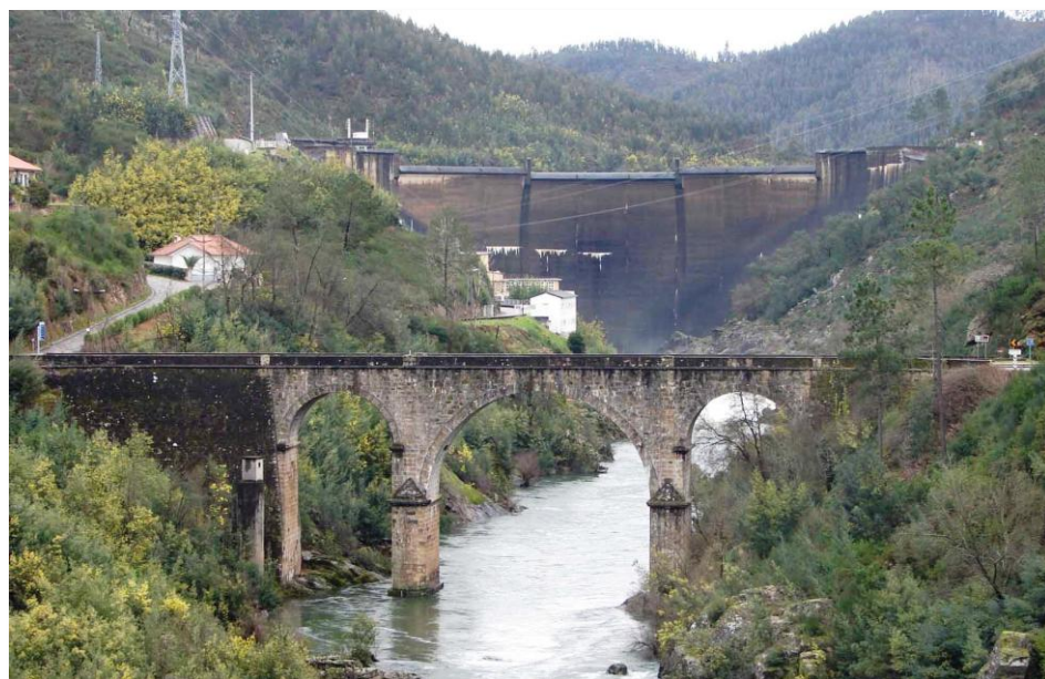
Figura II.10 – Puente sobre el Zêzere en Bouçã, com la presa en el fondo
