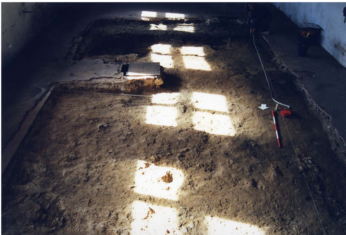
Figura III.70 - Sondagem 2 (início da escavação)
