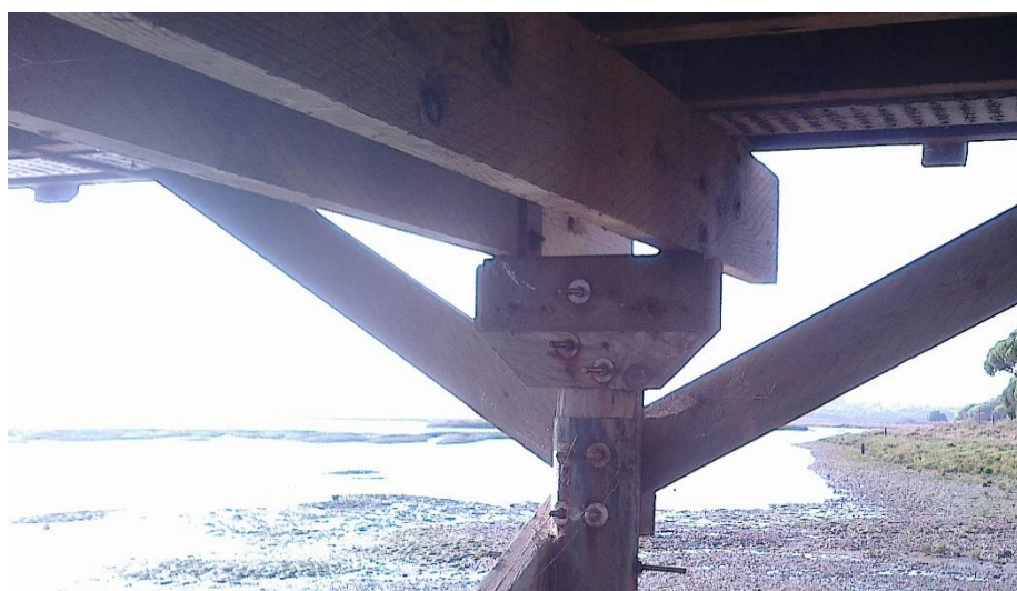
Fig. 5.37 – Carlingas apoiadas nos cachorros
