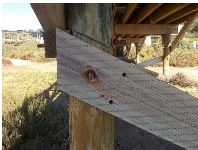
Fig. 5.35 – Ligação do pilar com barra de contraventamento
