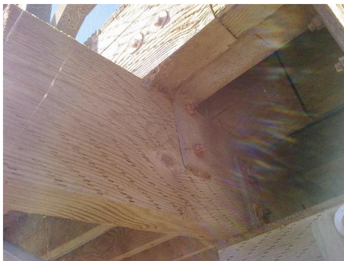
Fig. 5.33 – Longarinas apoiadas nas carlingas
