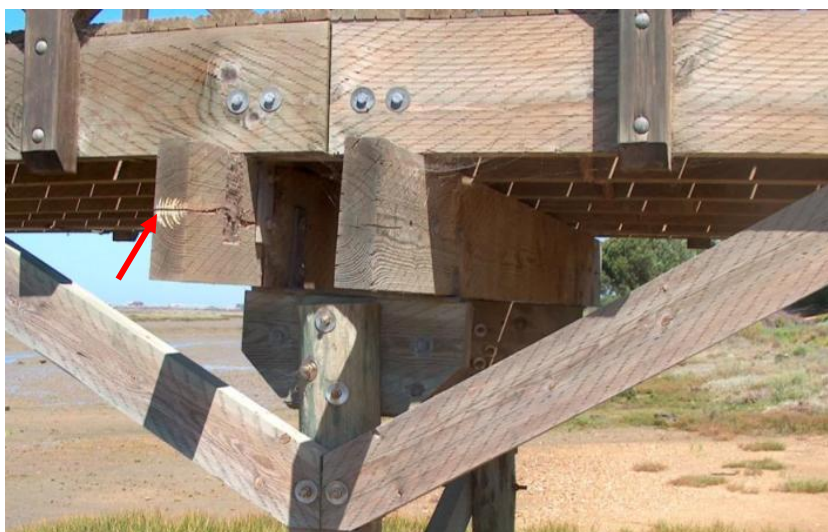
Fig. 5.10 – Fendilhação transversal
