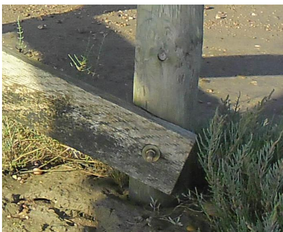
Fig. 5.38 – Ligação do pilar com viga contraventada
