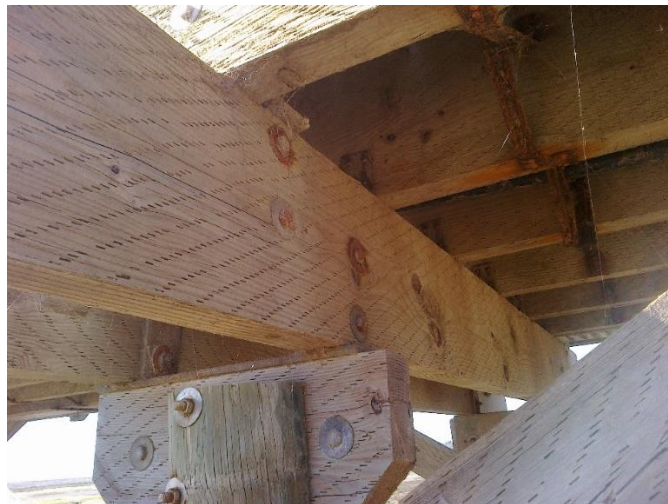
Fig. 5.34 – Carlingas apoiadas nos cachorros
