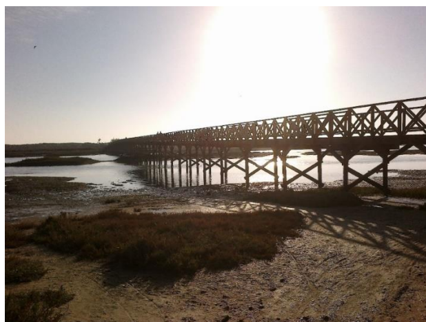
Fig. 5.2 – Ponte de madeira da Quinta do Lago
