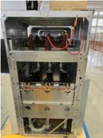
Figura 2.7 - Disjuntor de corte de MT.
