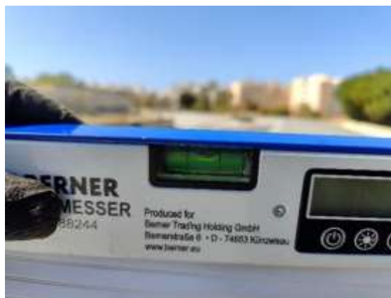
Figura 3.51 - Nível, para ajuste do nivelamento da estrutura de alumínio.
