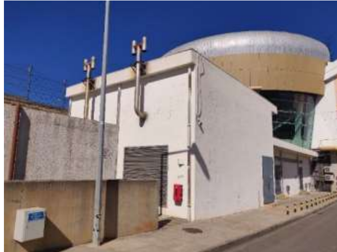
Figura 2.1 - Posto de Transformação 3.
