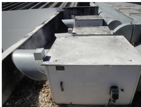
Figura 17 - Ventiladores Extração
