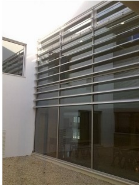
Figura 5.14 – Envolvente exterior (sombreamento envidraçados).
