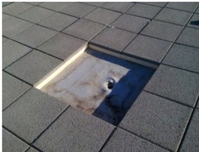
Figura 5.9 – Envoltente exterior do Bloco C (cobertura).
