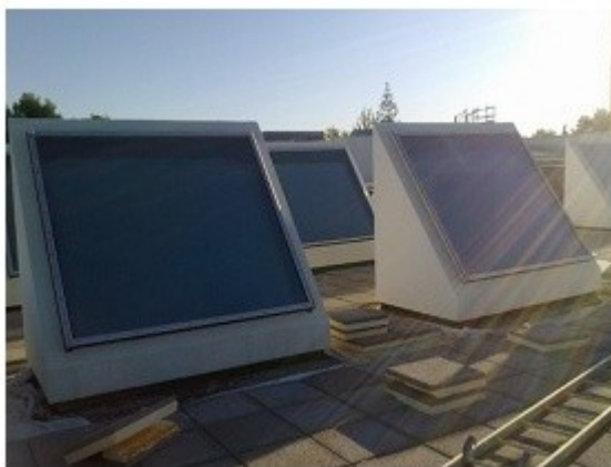
Foto 32– Desenho passivo (iluminação e ventilação naturais).
