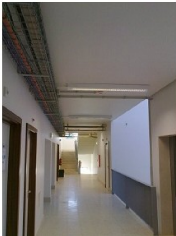
Figura 5.26 – Interior do edifício escolar (corredor acesso a salas de aula)
