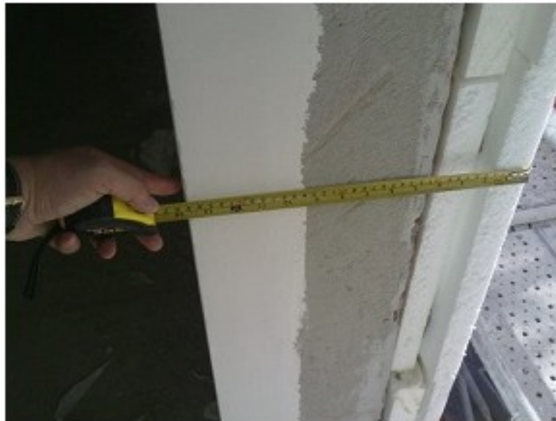
Figura 5.7 – Espessura da envolvente exterior Bloco C (parede).
