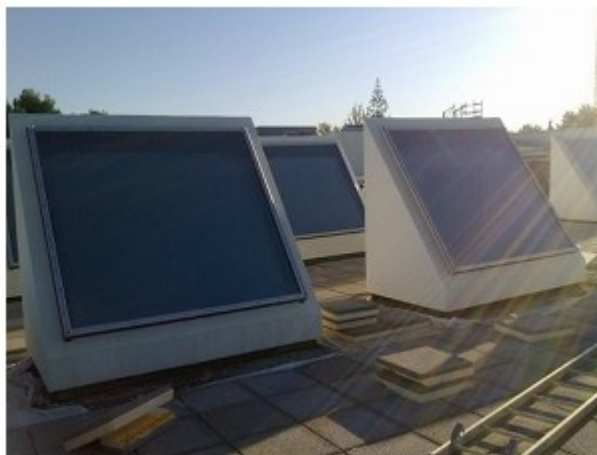
Figura 5.23 – Desenho passivo (iluminação e ventilação naturais)
