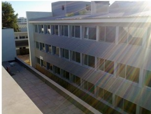
Figura 5.14 – Envolvente exterior (sombreamento envidraçados).
