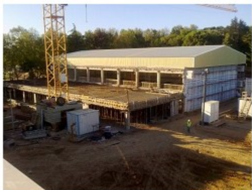
Figura 5.4 – Bloco G (reabilitado) e novos balneários
