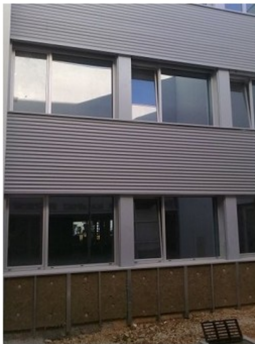
Figura 5.25 – Envolvente exterior (envidraçados oscilo-batentes).
