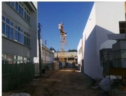
Figura 5.5 – Bloco C (novo) com Bloco E (reabilitado)
