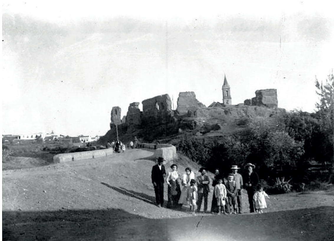
Figura 2 – Imagen del castillo de Gibraleón tomada el 13 de junio de 1918 por Francisco Barras de Aragón ( https://citius.es/fototeca ) se observa el estado de conservación de los lienzos defensivos norte, oeste y torre suroeste.
