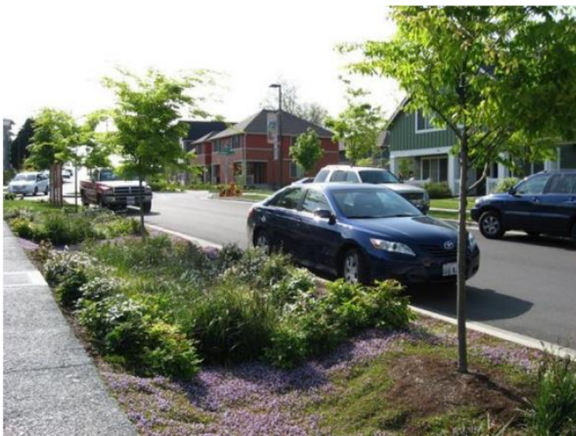
Figura 7- Swale vegetado como estrutura de desconexão entre dois meios impermeáveis (retirado de Kloss & Lukes, 2008)
