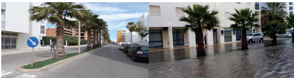
Figura 14 - Secção da Rua do Nascente e Rua do Leste (F3) antes e depois de fenómeno de precipitação intensa (adaptado de L. Medina, 2016; Palmeiro, 2010)
