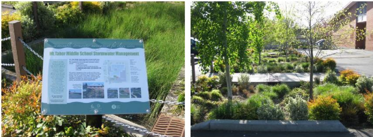
IX.3. - Jardim Chuva e canteiro de infiltração na Escola Básica de Mt. Tabor (adaptado de Hoyer et al., 2011)
