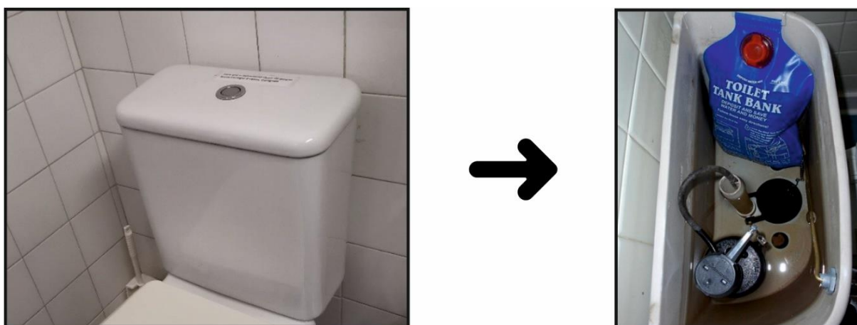
Figura II.5 - Instalação de um redutor de descarga num autoclismo.
