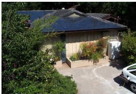
Figura 3.2 - Cobertura de uma vivenda com células fotovoltaicas
