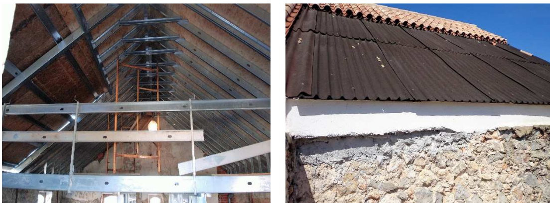
Figura 4.13: Estrutura em LSF introduzida ao nível da cobertura inclinada.
