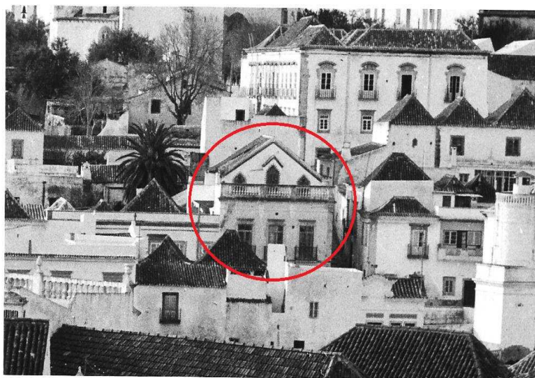
Figura 4.2: Estado do edifício anterior à intervenção de 2004..
