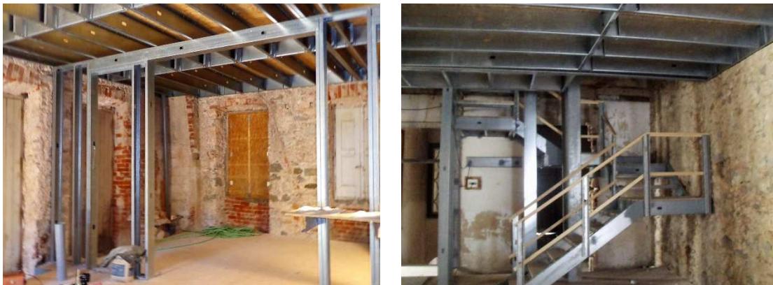
Figura 4.12: Estrutura em LSF introduzida ao nível do primeiro piso.
