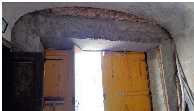
Figura 4.10: Lintel em betão armado introduzido na parede frontal do piso térreo.
