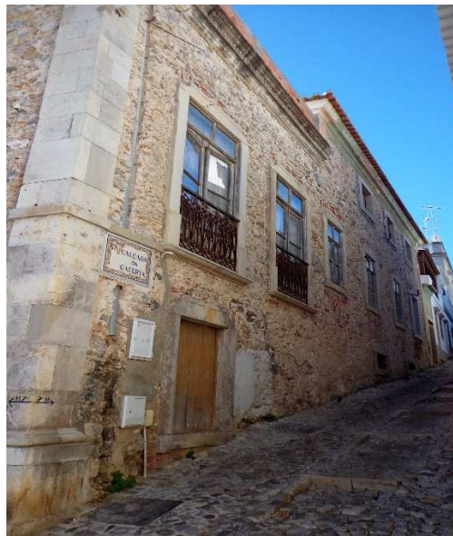
Figura 4.5: Representação do edifício na sua maior dimensão (alçado nordeste).
