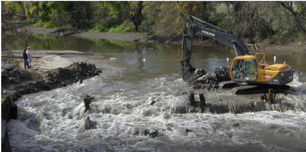
Figura 20: Remoção destas barragens - Fonte: Jepsen, 2009
