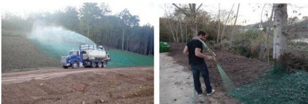
Figura 10: Hidrosementeira - Fonte: Freitas, 2011
