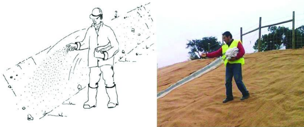
Figura 14: Sementeira manual a lanço - Fonte: Freitas, 2011
