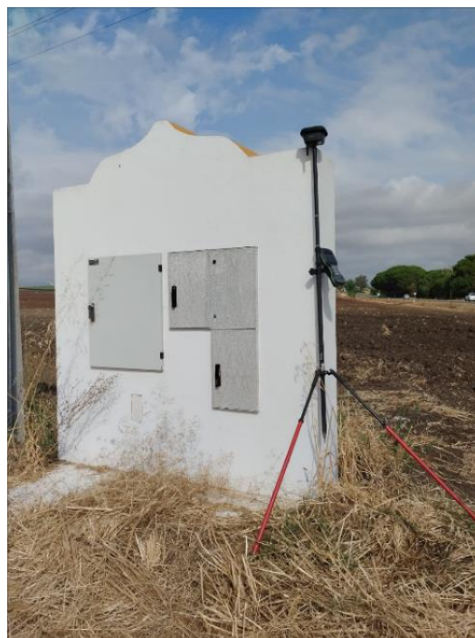
Figura 5.8 – Detalhe do PF_14_2024 (Fonte: CC).
