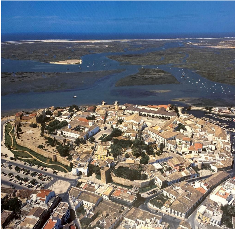
Figura 1 - Vista aérea da Muralha de Faro
