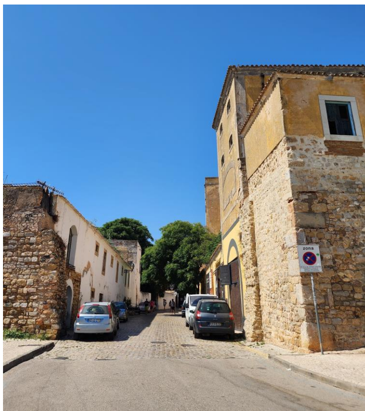
Fotografia 3 - Rombo na Muralha
