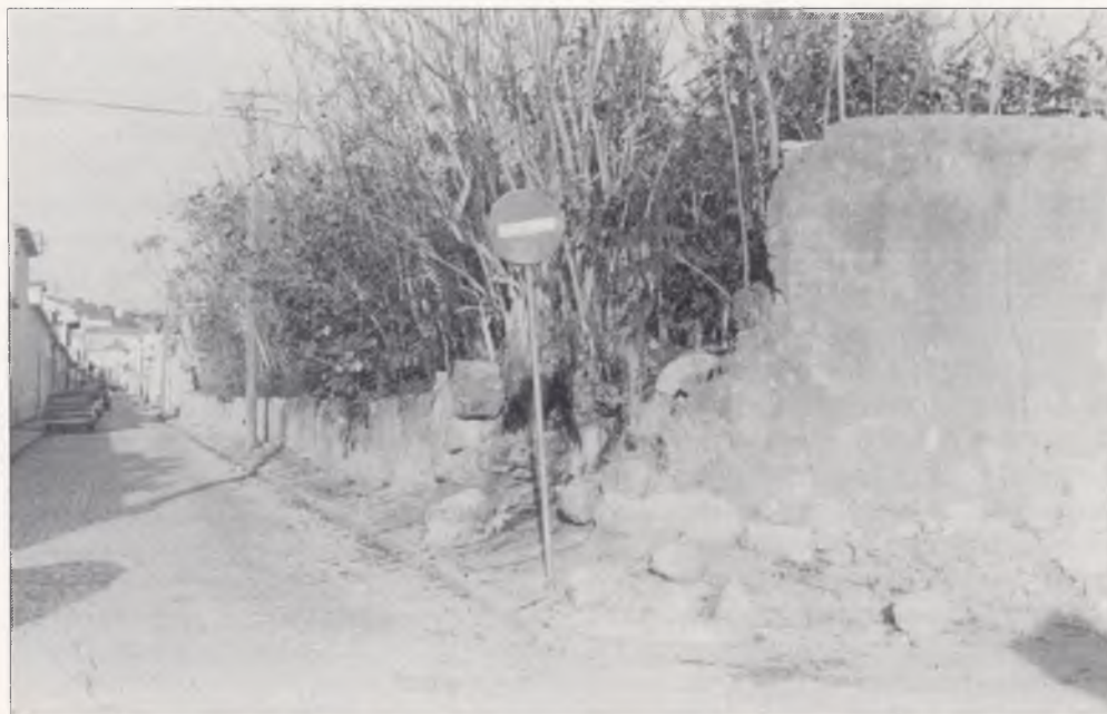
Um aspecto geral da Rua Nova de Quarteira, vendo-se à direita uma parte do muro do "Jardim do Boné" em estado de ruína e já devassado.
