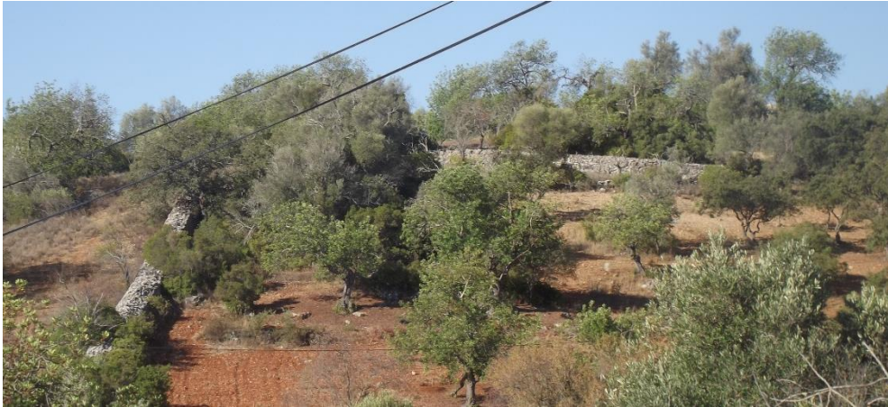
Figura 4.13 | Muros de compartimentação em pedra solta, Paderne. (Cristiana Rodrigues, 2015)
