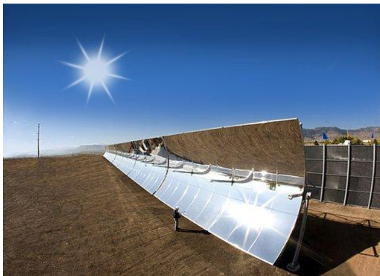
Figura 3.3 – Estação experimental de foco linear da Ausra, Australia.
