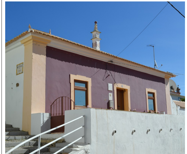
Vista da chaminé em contexto
