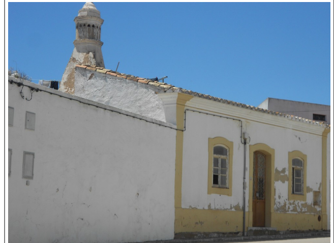
Vista da chaminé em contexto
