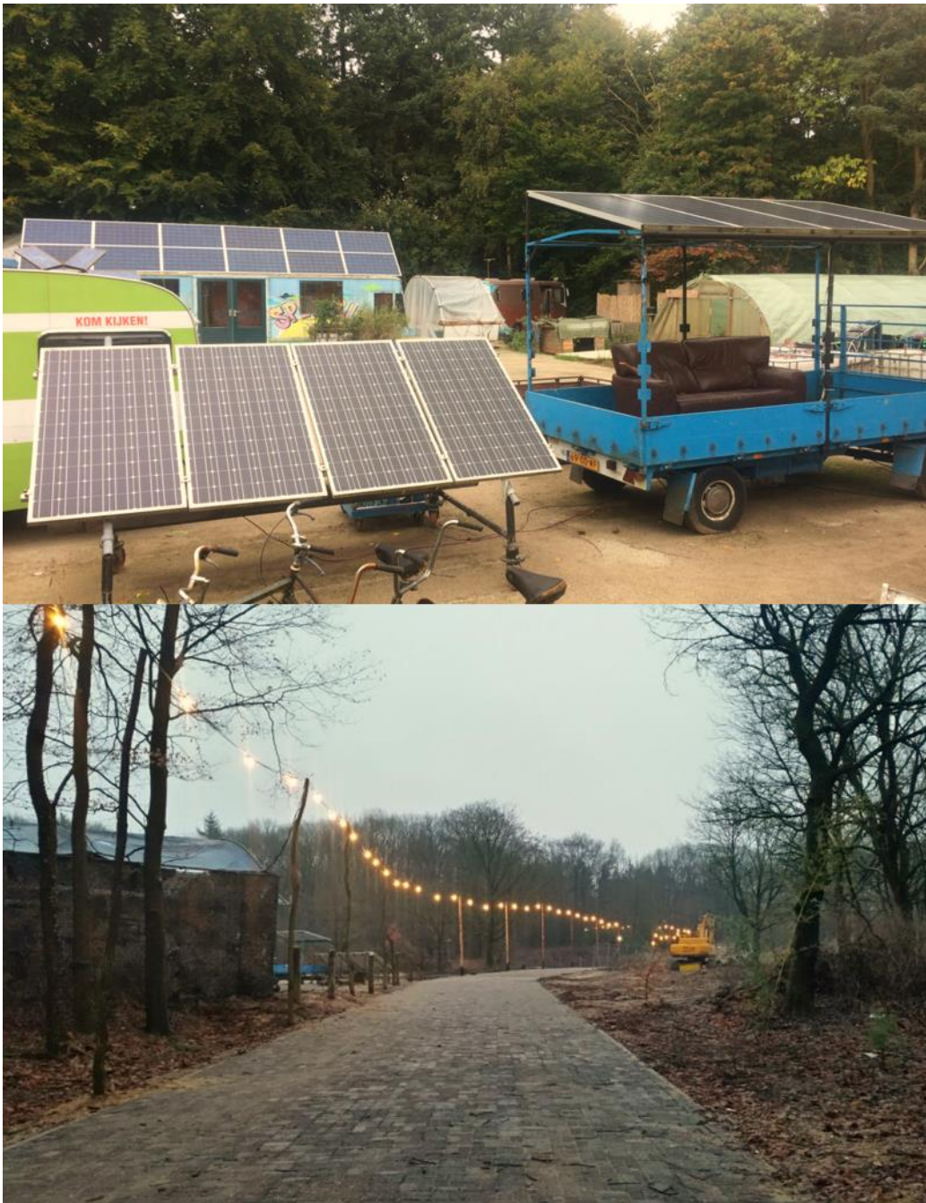
Figura 9.23 - Painéis Solares e Iluminação Pública em PPAUW
