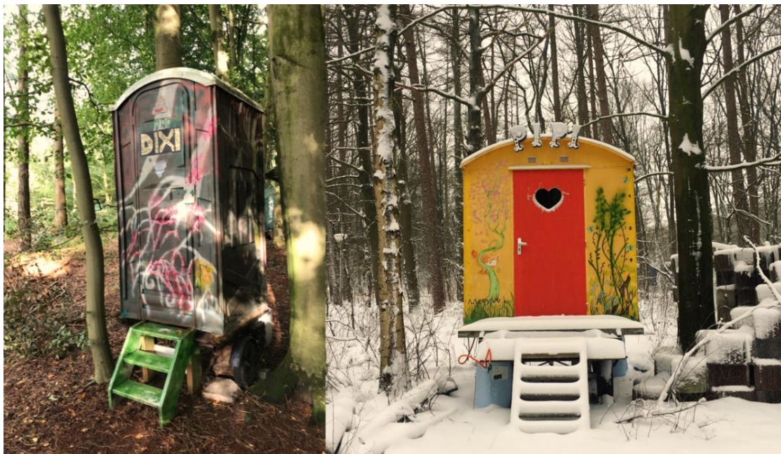
Figura 9.22 - Casas de Banho Secas em PPAUW
