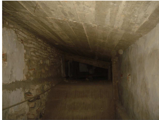
Figura 9 – Parede em alvenaria da fachada poente
