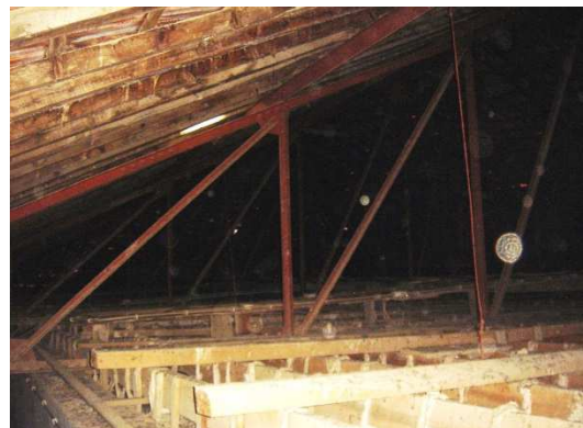
Figura 12 – Estrutura da Cobertura
