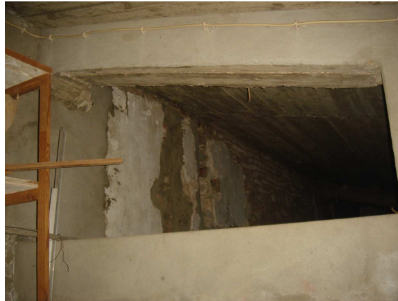
Figura 10 – Apoio da laje do balcão em vigas e na fachada poente
