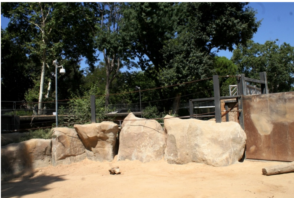
Tancament de cables més pastor més roques artificials a la base
