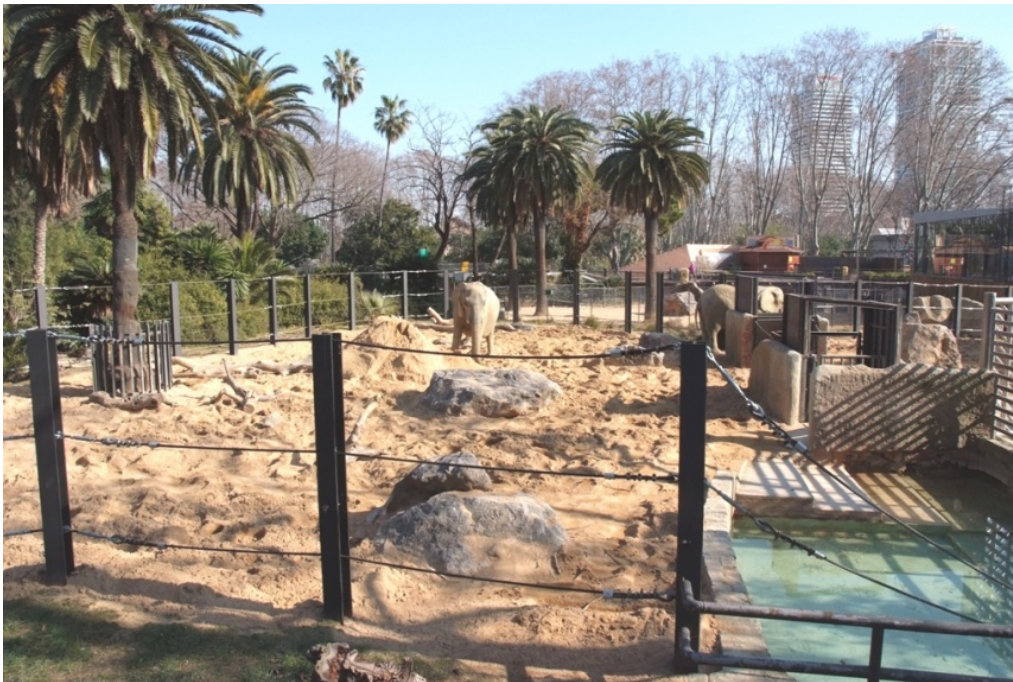
Tancament de cables més pastor
