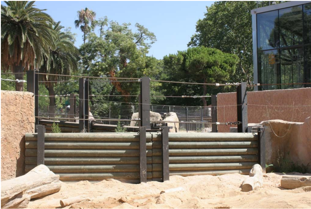
Tancament de cables més pastor més postes de fusta tractats
