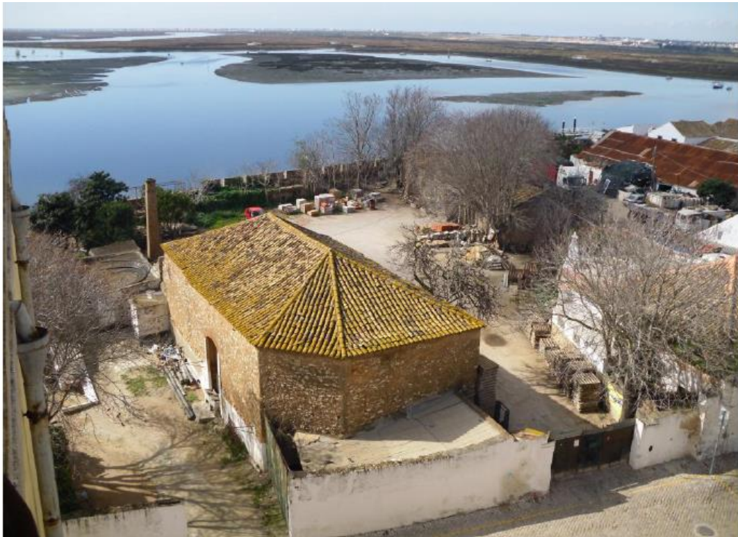
Figura 1- Conjunto edificado, formado por dois armazéns e um logradouro, antes de sofrer a intervenção do projeto de adaptação de armazém a restaurante-bar.
