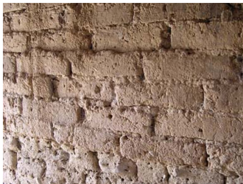
Clarines, alvenaria de adobe
