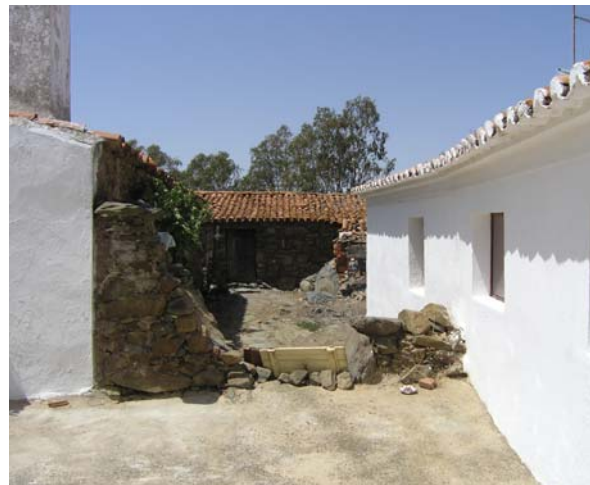
Clarines, habitação e ramada (ao fundo)
