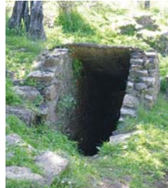
poço de entrada
