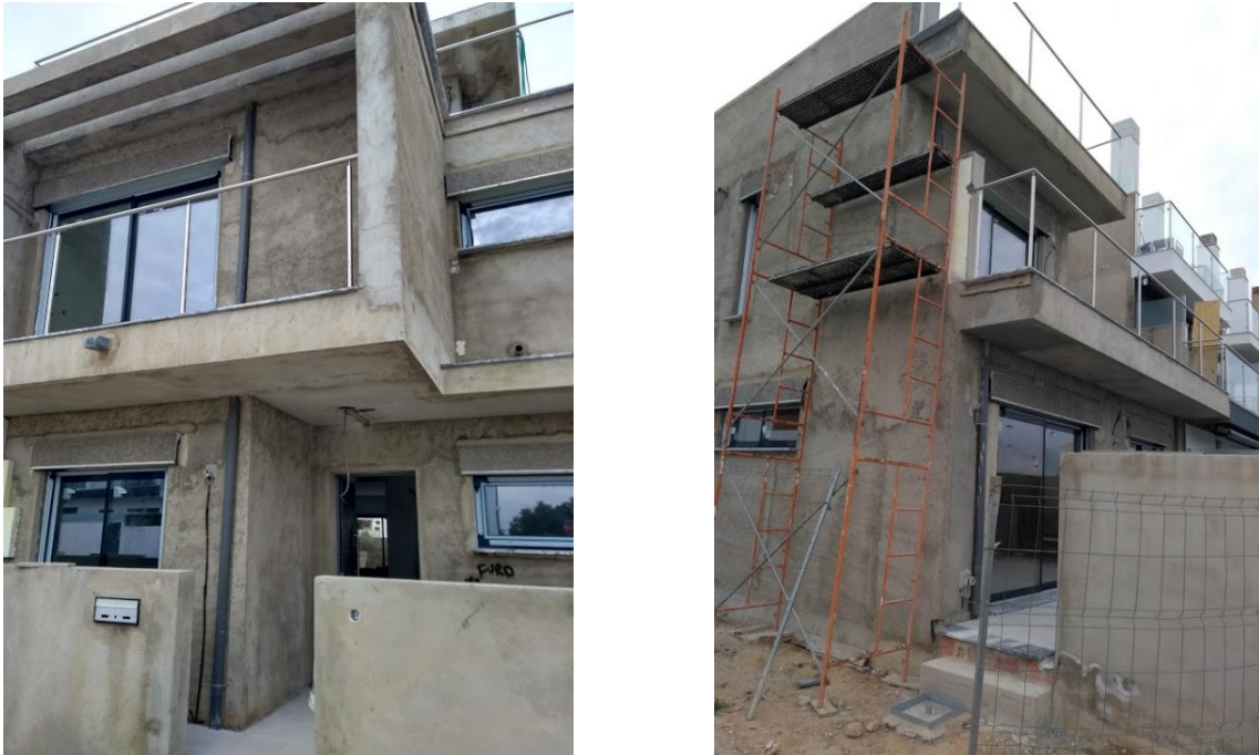
Figura 23 - Dispositivos de sombreamentos utilizados na habitação
