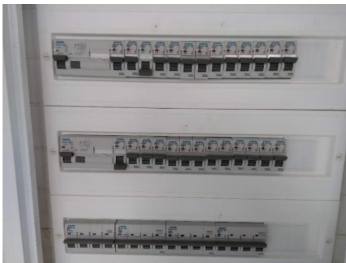
Figura 52 - Foto do quadro geral da moradia
