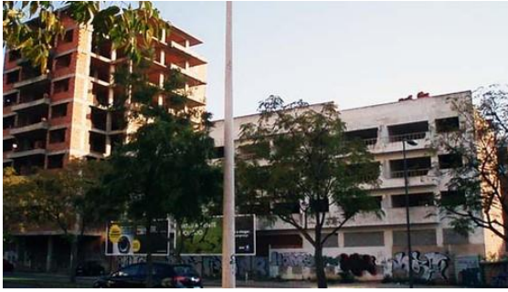
Figura 1.4: Imóvel devoluto sito na freguesia de Quarteira, atualmente alvo de demolição e reconstrução.
