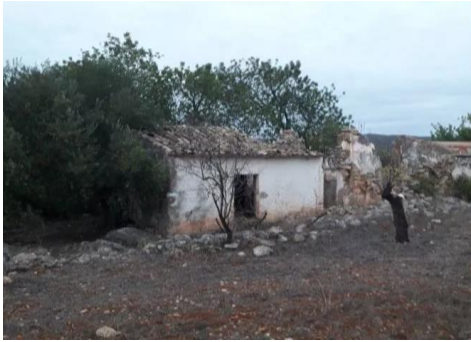
Figura 1.2: Prédio misto sito na União de Freguesias de Querença, Tôr e Benafim.
