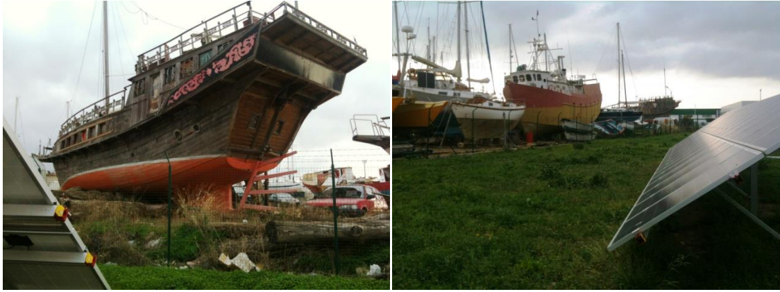
Figura 3.4 – Fotografias do estaleiro naval e SSFV da ETAR de Olhão Nascente
