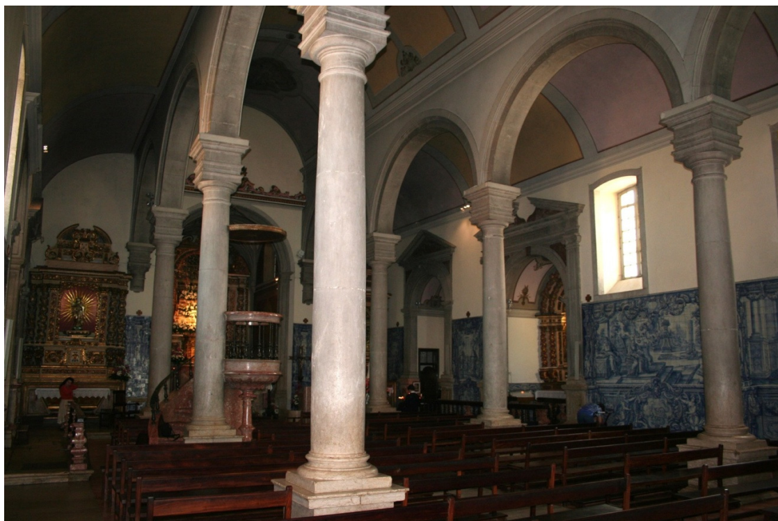
Fig.18 – Vista geral interior.
