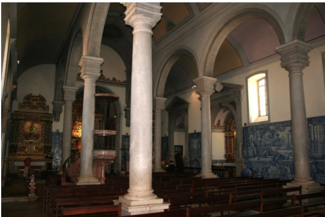
Fig.20 – Vistas gerais do revestimento azulejar da nave.
