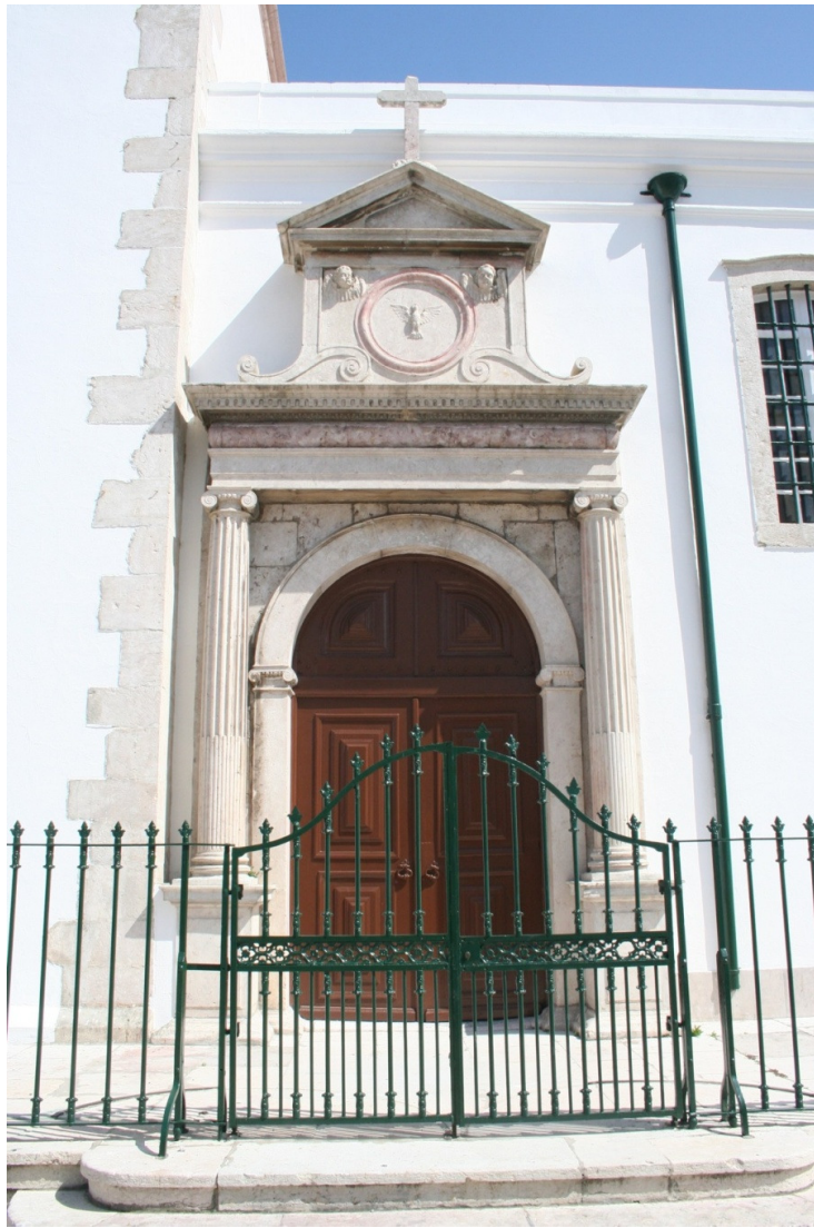
Fig.14 – Vista do portal lateral Sul.
