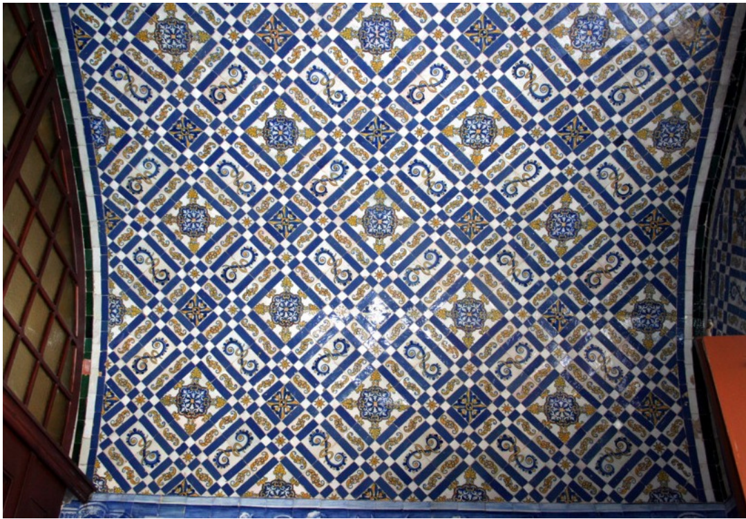
Fig.27 – Revestimento interior, em azulejo de padrão, do guarda-vento.
