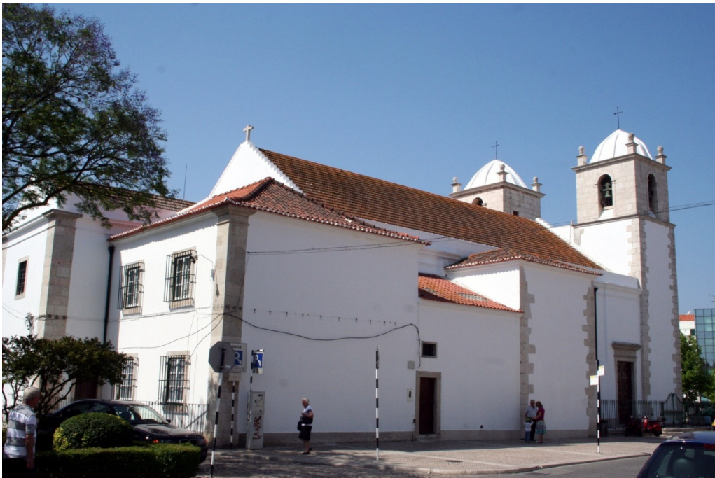
Fig.10 – Vista Norte. Volumes escalonados com coberturas diferenciadas.
