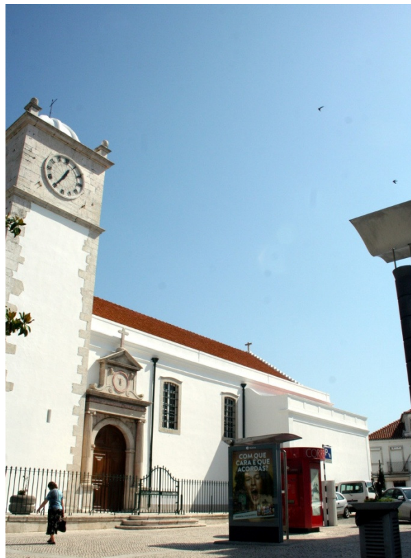
Fig.13 – Vista Sul. Fachada lateral com portal.
