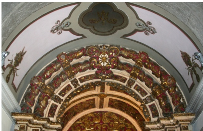
Fig.75, fig.76 e fig.77 – Áticos de volta perfeita e concêntricos, cortados transversalmente por aduelas.
