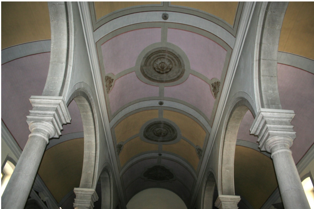
Fig.23 – Vista geral das abóbadas da nave.
