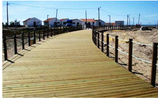
Figura 4.20_Exemplo de deck de madeira com proteções. Praia no Porto. (MSJ-Wood Solutions, 2015)
