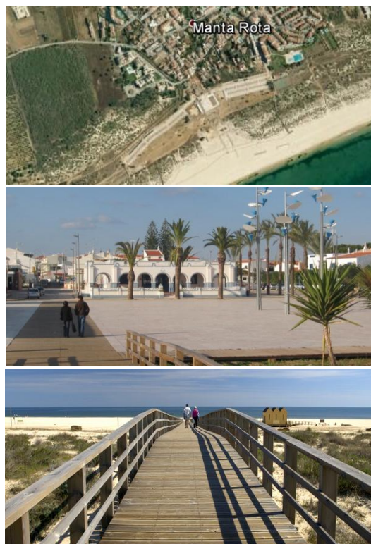
Figura 3.1_Localização. Praça. Passadiço na praia da Manta Rota.
