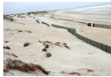
Figura 4.15_ Em cima, placar informativo. Em baixo, barreira de rede fixa com estacas de madeira. (2014)
