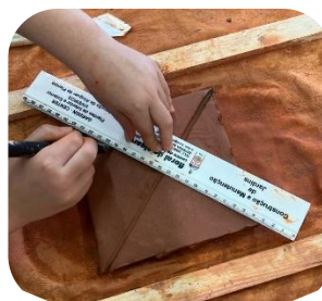
Figura 3.18. Marcações no azulejo na diagonal, para formar 3 triângulos.
