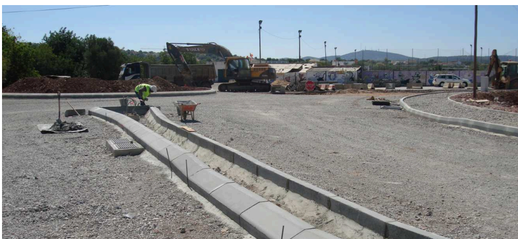
Foto 30 - Circular norte - Execução de rotunda (05-08-2014)
