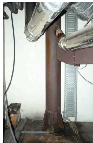
Foto 10 – Base da chaminé
