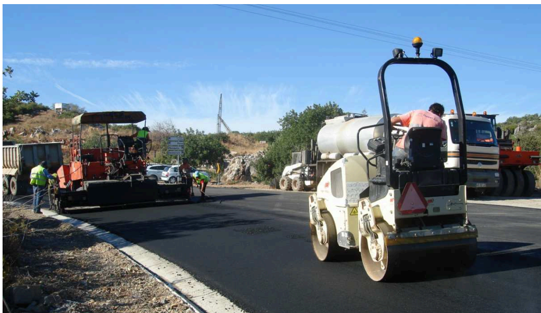
Foto 29 - EM 514 - Trabalhos de pavimentação (16-10-2012)
