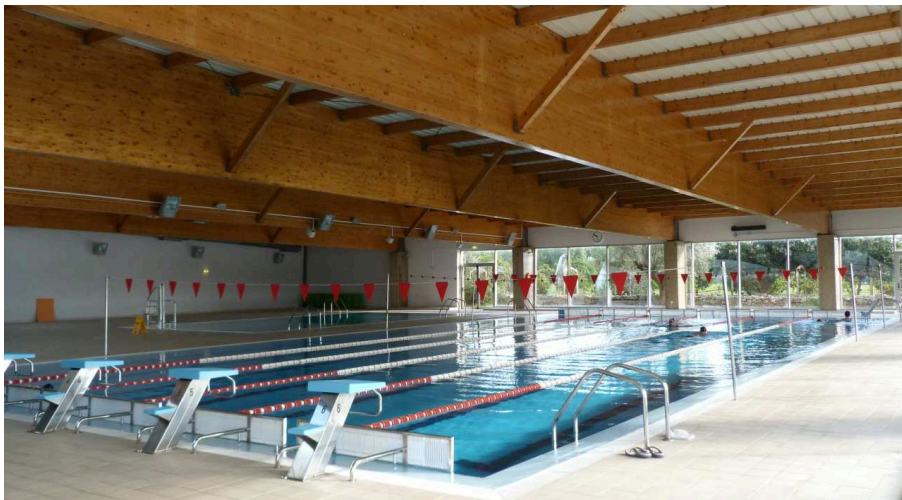
Foto 2 - Vista do cais da piscina (07-12-2011)
