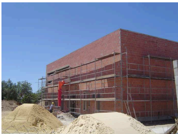
Foto 26 - Creche - Fase de alvenarias e forra térmica da estrutura (13-07-2009)
