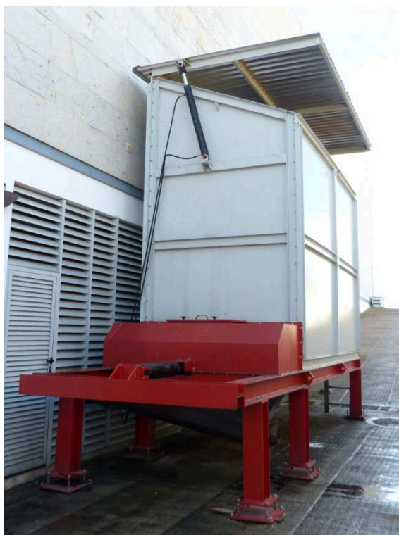
Foto 13 - Silo de armazenagem (03-04-2014)
