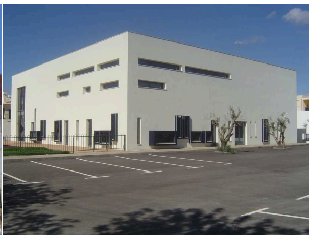
Foto 25 - Creche - Obra concluída (14-10-2010)
