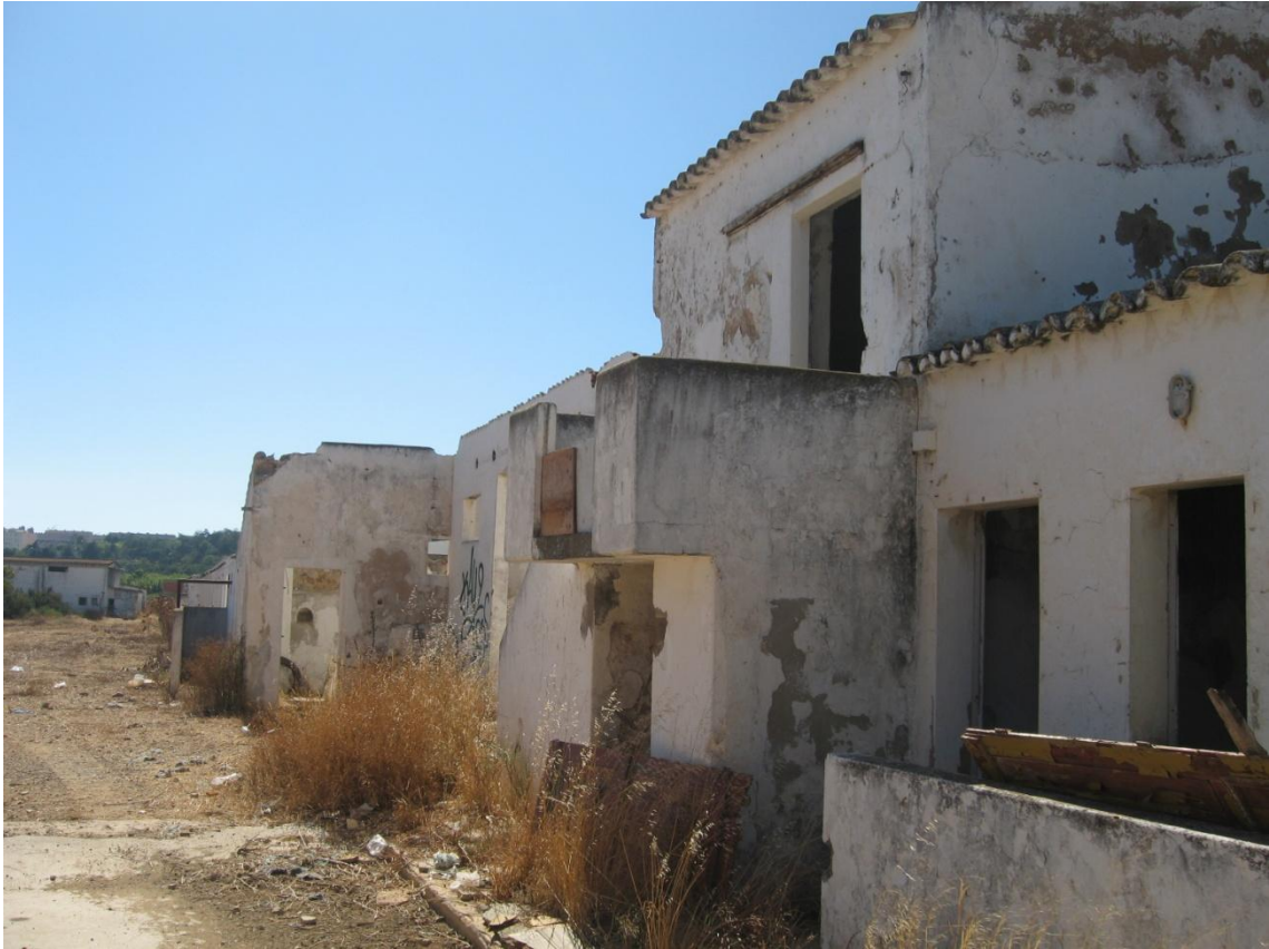
Imagem V.12 – Edifícios da antiga suinicultura na entrada nascente do parque
