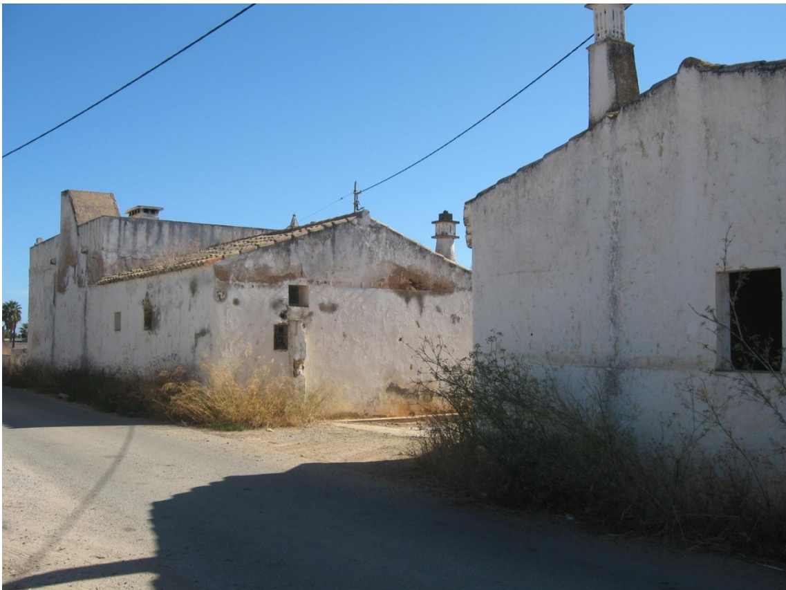
Imagem V.11 – Estado da entrada nascente do parque
