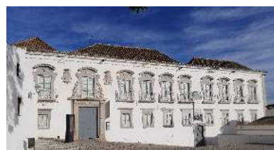
Imagem 51. Museu Municipal de Tavira, Edifício sede - Palácio da Galeria.
