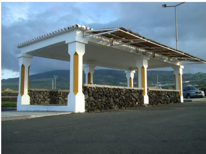
Figura 4.20 – Fotografia da estrutura de apoio de apoio ao mercado local existente (Fonte PROJECTANGRA, João Monjardim, 2008).
