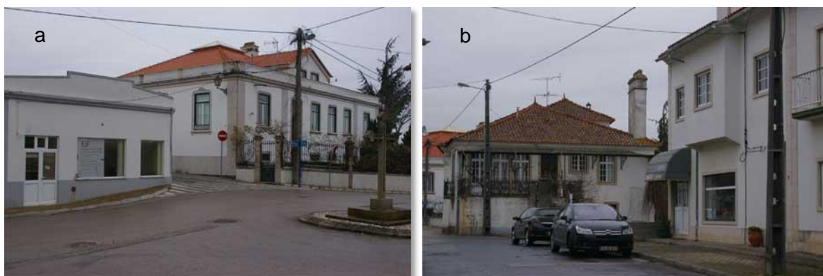
Figura 5 – Dois exemplos da contaminação visual das antigas edificações. a) Rua Torta; b) Rua de Santo António. Fonte: autores, 2011
