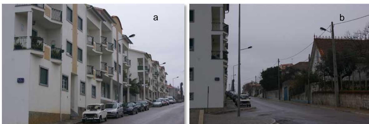
Figura 6 – Contraste entre os edifícios mais recentes e os mais antigos, nos lados exactamente opostos da Rua Libânio Vaz Serra. a) lado ponte; b) lado nascente. Fonte: autores, 2011
