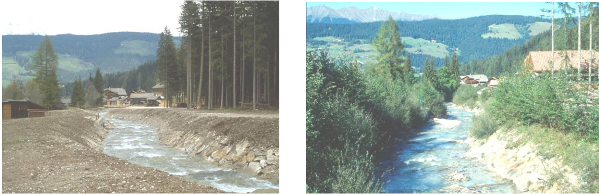
FIG 2.5 e FIG 2.6 A aplicação de técnicas de Engenharia Natural, antes da intervenção (à esquerda) e cinco anos após esta (à direita). Grendelbach bei Effetikon, Zurich (Suíça).
