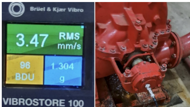
Figura 23 – Leitura do sensor na axial.
