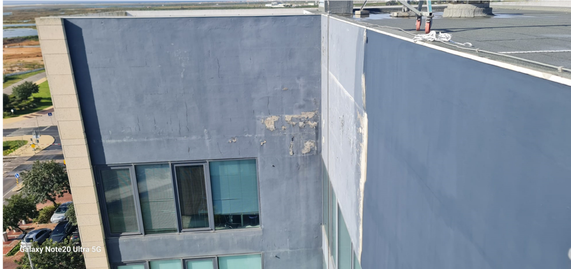
Figura 104 – Diferença entre o antes e o depois da fachada sul.
