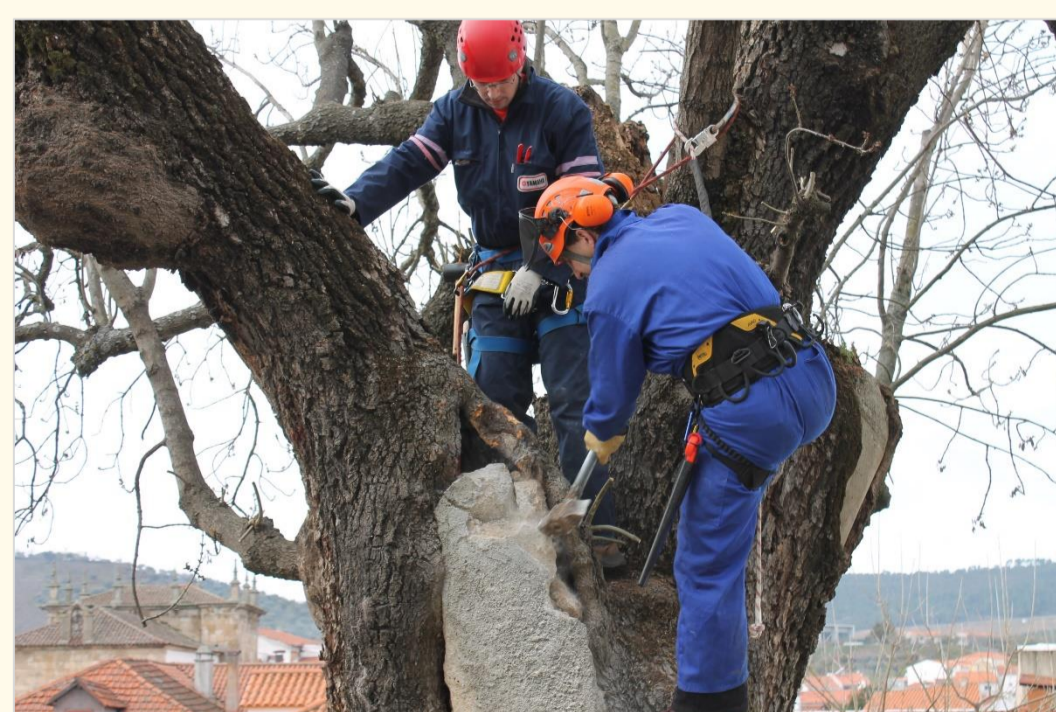
Retirada de cimento do tronco.
